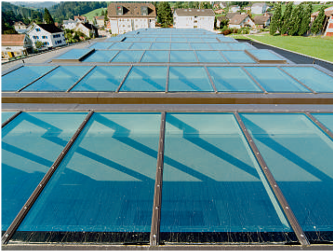
Die aussen liegenden Aluminiumrahmen sind in einem zum Dach passenden Farbton einbrennlackiert. Die Deckleisten sind verschraubt.
