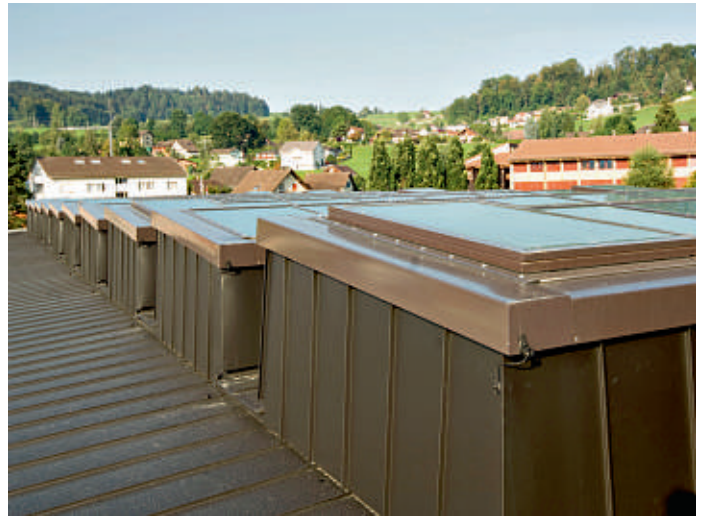
Dach und Schächte sind mit gleichfarbigen Metallblechen verkleidet. Gut zu erkennen sind die Lüftungskappen auf den äusseren Fenstersegmenten.
